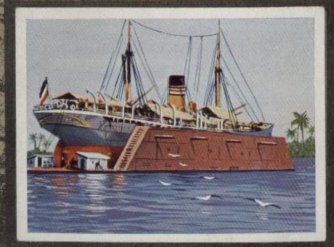
5 Schwimmdock in Daréssalam. Das von der Kolonialverwaltung in Daréssalam errichtete Schwimmdock ermöglichte es, beschädigte Schiffe auszubessern. Es war 64,8 m lang und hatte eine Tragfähigkeit von 1800 t.
