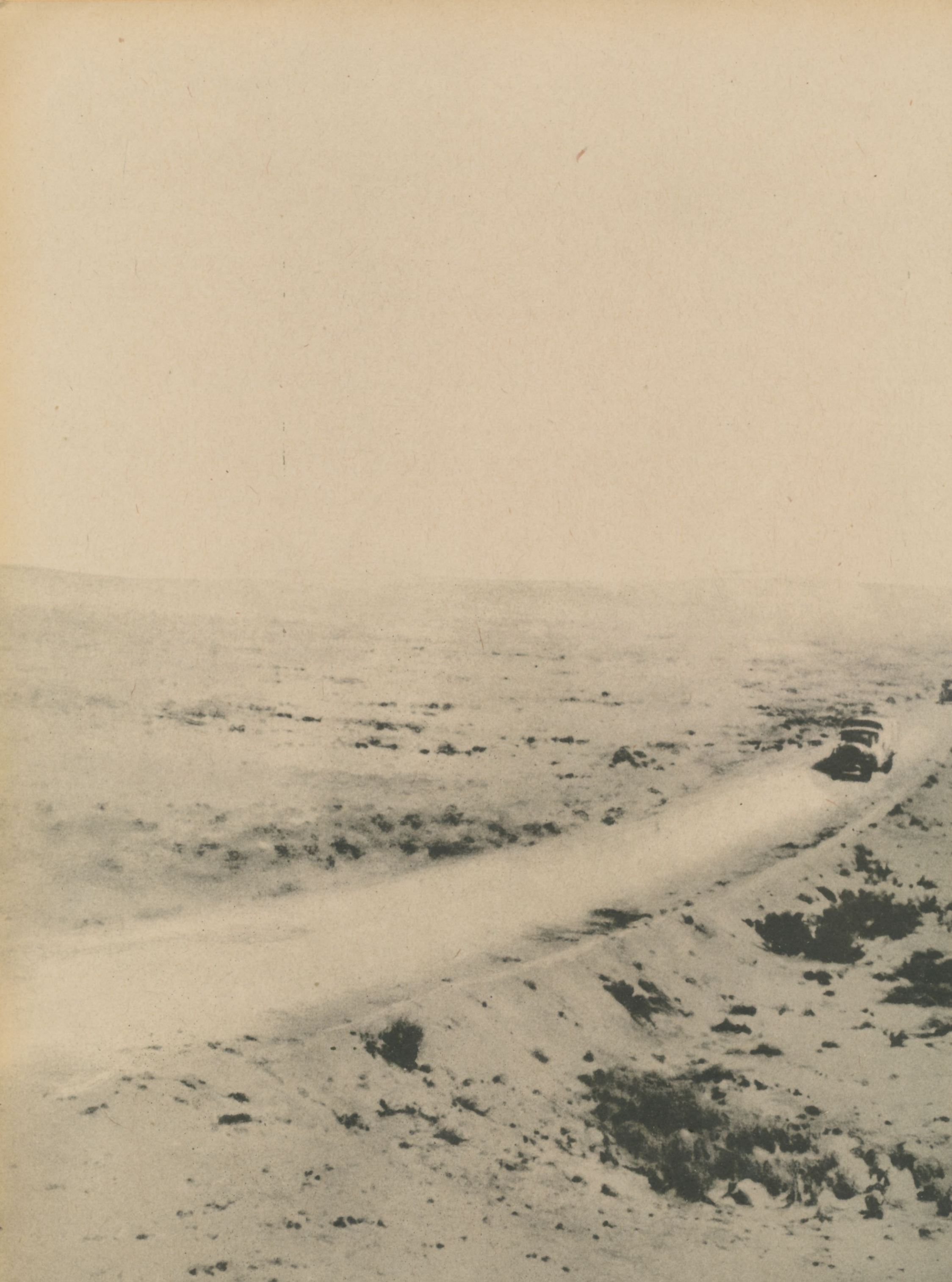
Die Via Balbia zwischen Bivio En-Noflra und Arco dei Fileni La Via Balbia fra Bivio En-Noflra e Arco dei Fileni
