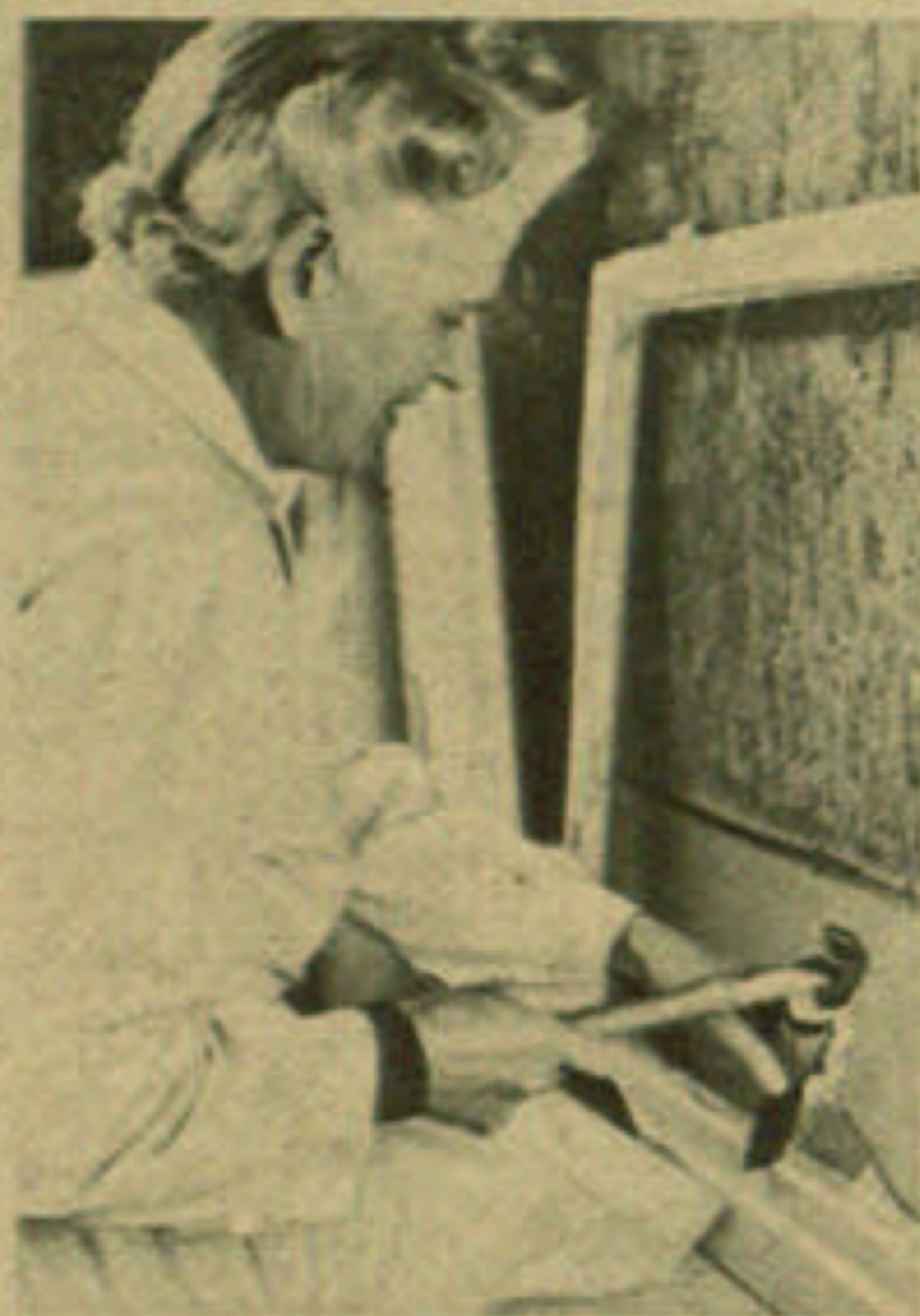
Ist eine Fensterscheibe entzwei, kann man selbst die Scheibenreste entfernen
