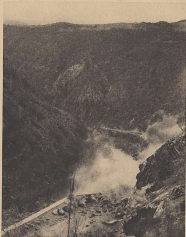
6000 km Straßen hatten die Pioniere während des Aufmarsches auf dem Balkan zu erkunden. 155 km mußten neu gebaut, andere Straßenstrecken durch Sprengung verbreitert werden.
