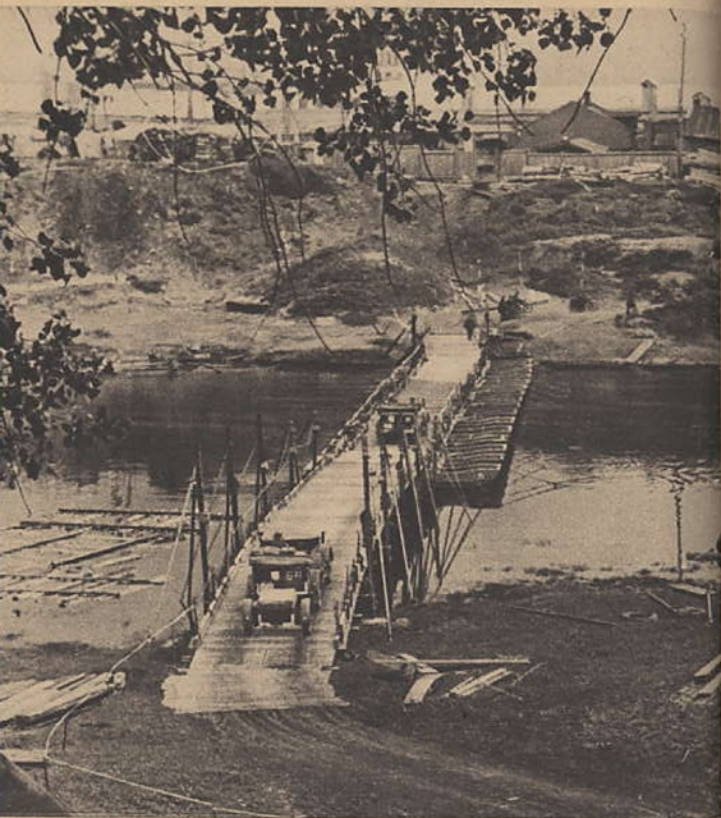
Im Nordteil von Smolensk, hinter dem Dnjepr, versuchte der Feind, sich noch einmal festzukrallen, bevor die Stadt räumte. Die Brücken über den Fluß waren unpassierbar; Pioniere bauten infolgedessen, ständig dem feindlichen Feuer ausgesetzt, eine Kriegsbrücke, und bald war nach außerordentlich hartem Kampf auch der Nordteil der Stadt und damit ganz Smolensk in deutscher Hand.
