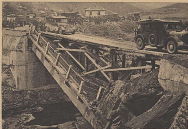
Keine Brückensprengung des Feindes hemmte den deutschen Vormarsch in dem Feldzug auf dem Balkan. In erstaunlich kurzer Zeit konnten überall Behelfsbrücken gebaut werden.
