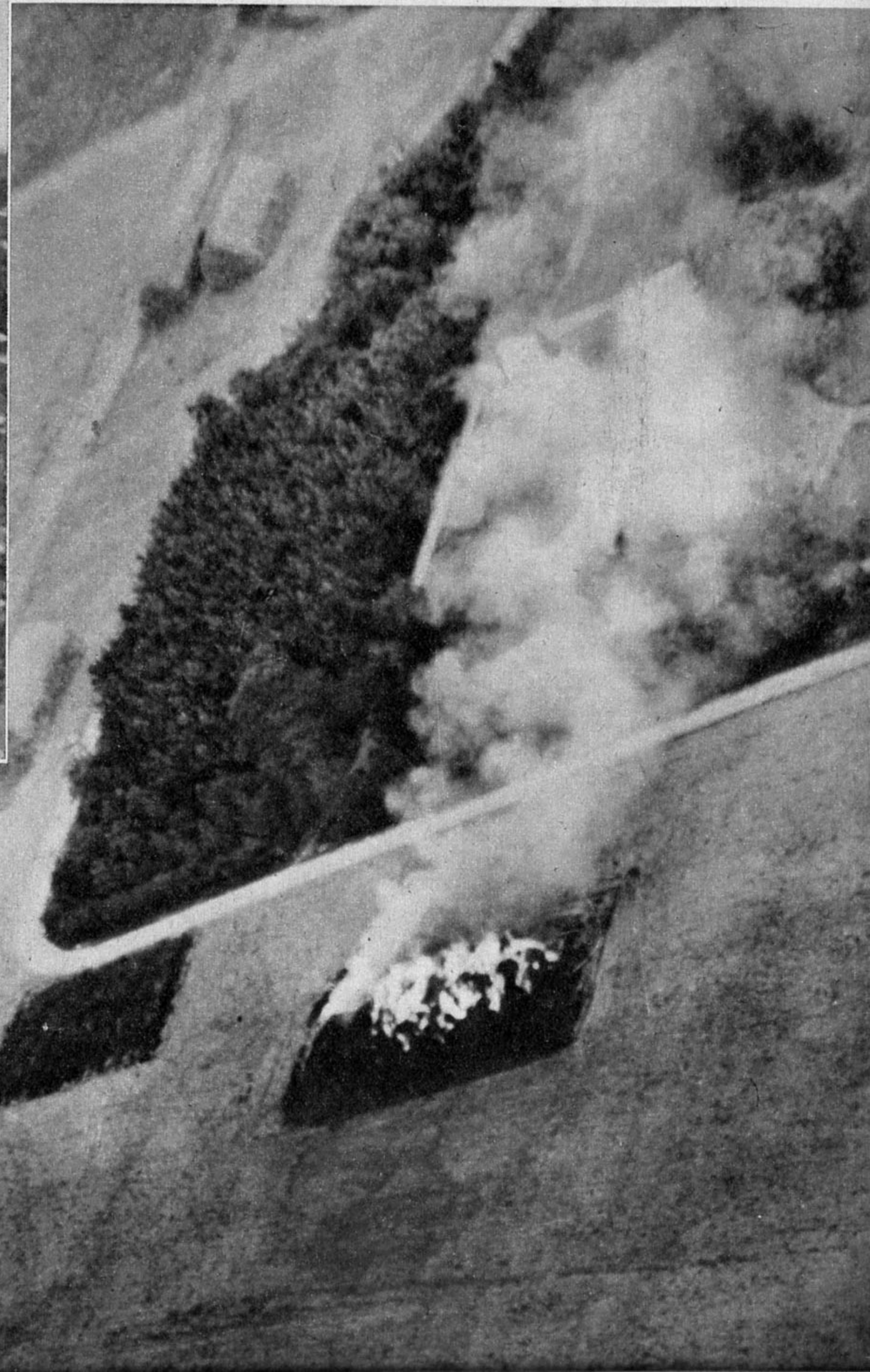
Unten: Eins der Festungswerke, das in einer Waldparzelle angelegt war, steht nach den ersten Angriffen unserer Stukas bereits in hellen Flammen
