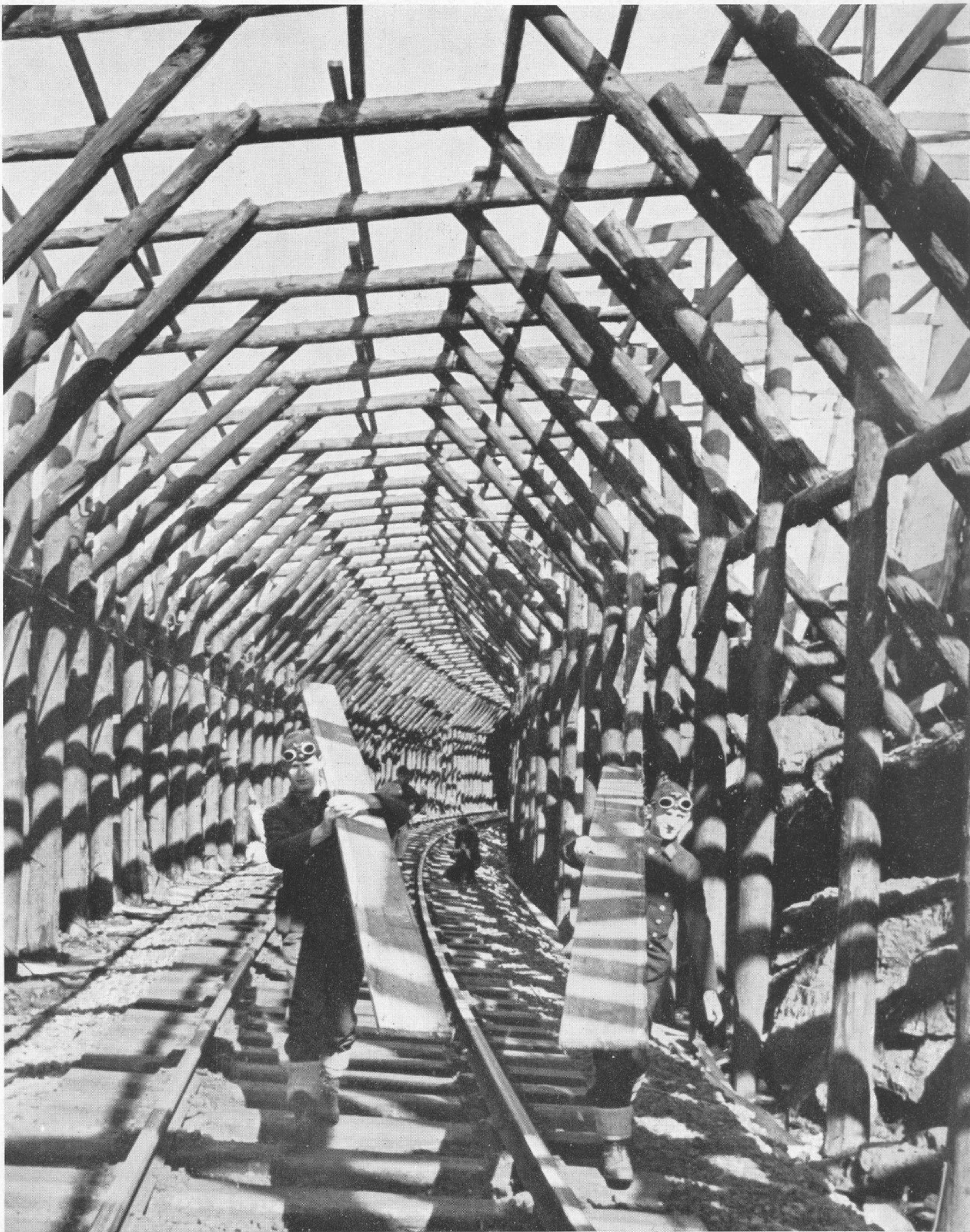
Die technische Division der Zerstörer baut aus den Brettern einen Tunnel, der die Erzbahn gegen Schneeverwehungen schützen soll, Unterkünfte für die Gebirgsjäger.
