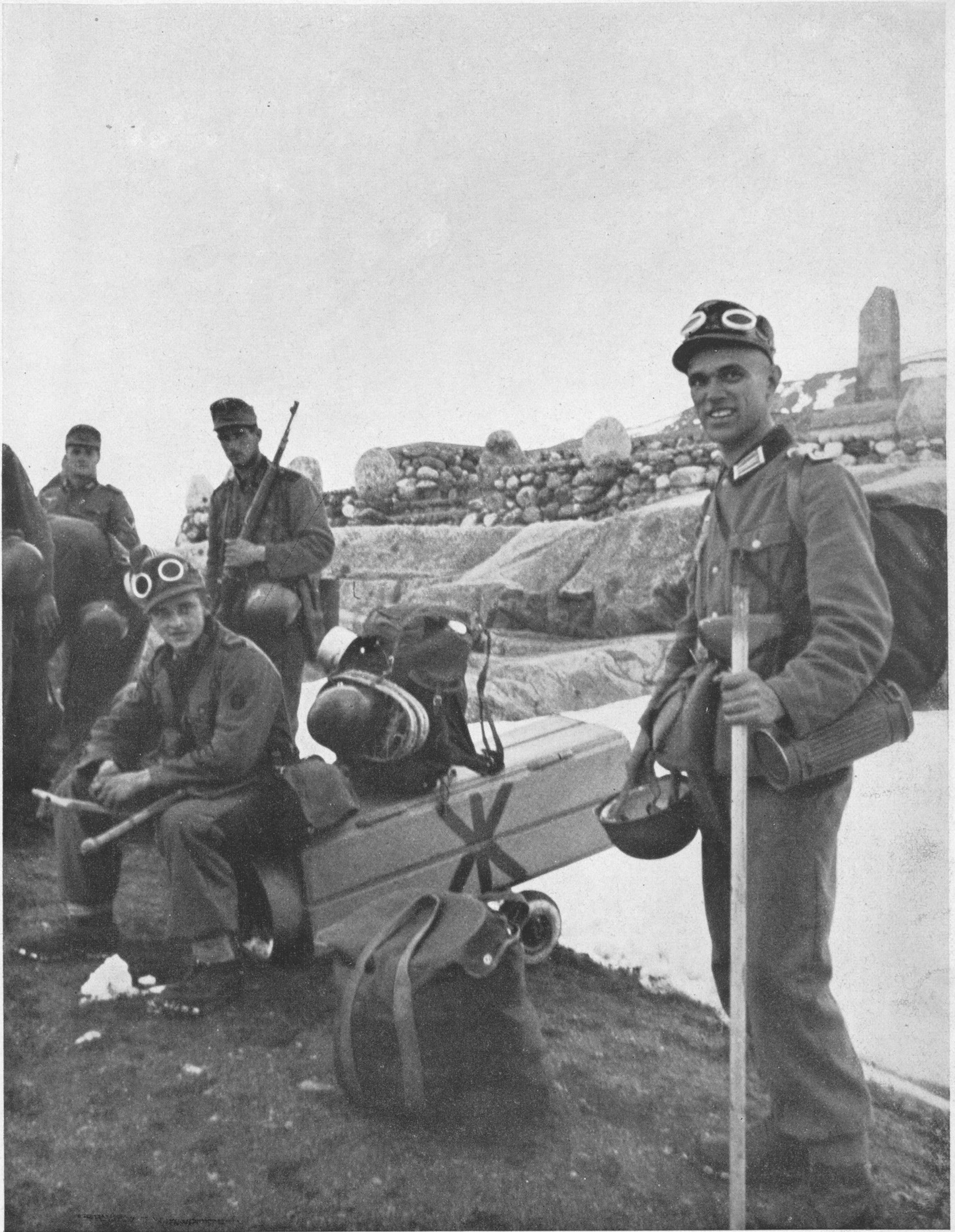
Neuer Ersatz ist eingetroffen. Im Hintergrund das Steindenkmal der Ofoten-Bahn.
