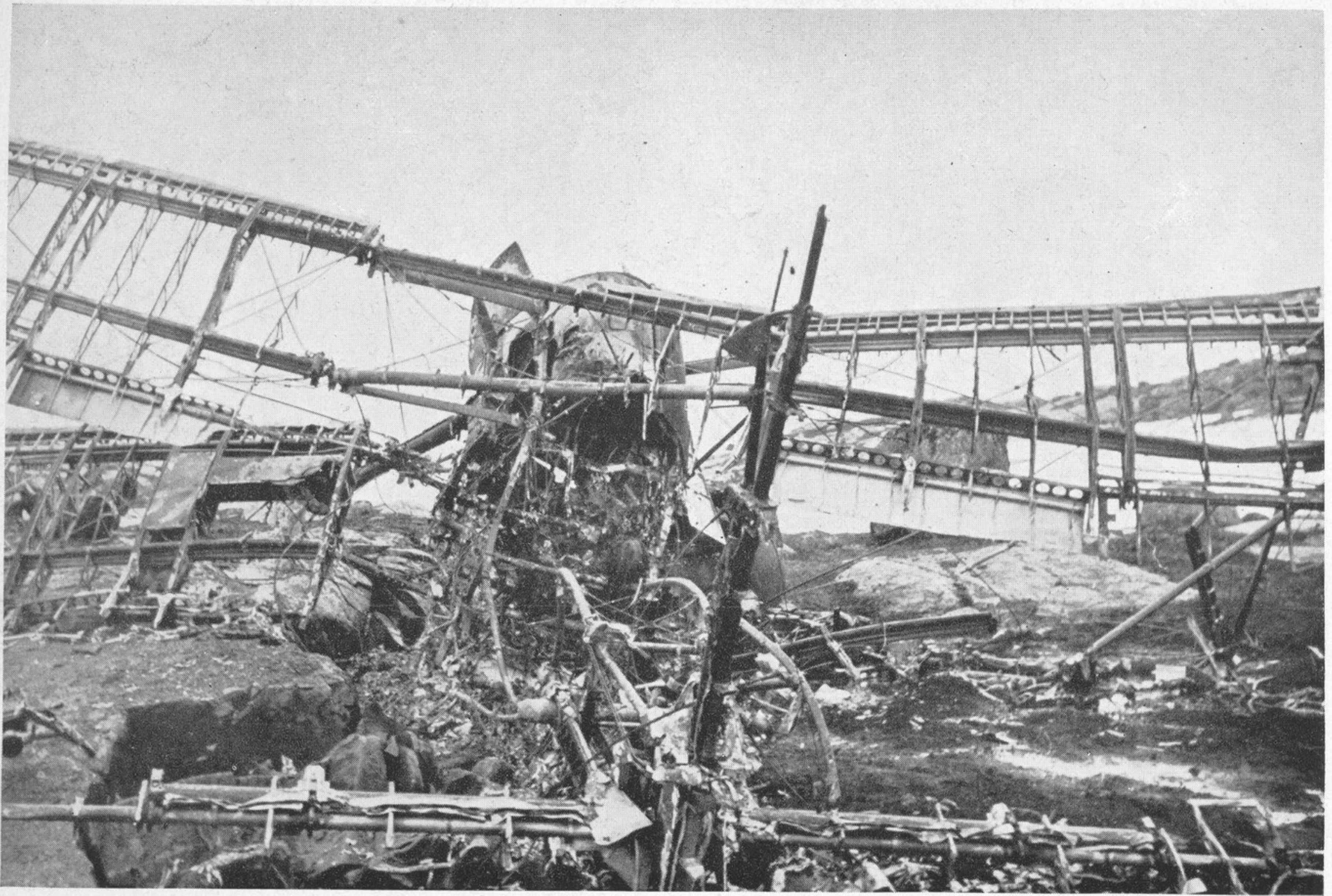
Tragflächen, Verstrebenen, nichts ist heil geblieben an dieser englischen Maschine.
