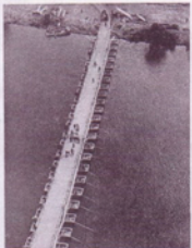
Deutsche Pioniere haben diese Pontonbrücke in Frankreich gebaut. Sie steht auch den zurückkehrenden französischen Flüchtlingen zur Verfügung, deren Landsleute ihre eigenen Brücken zerstört haben.
