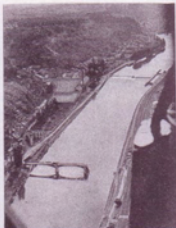
Luftbild des Städtchens Dinant. Auch hier sind die Brücken sinnlos gesprengt worden. Ein Brückenbogen ist in dem tiefen Wasser völlig versunken.
