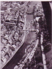
Die malerisch an der Mündung der Sambre in die Maas gelegene Festung Namur ist kaum beschädigt. Die einzigen Schäden sind die von den Belgiern selbst vorgenommenen Brückensprengungen
