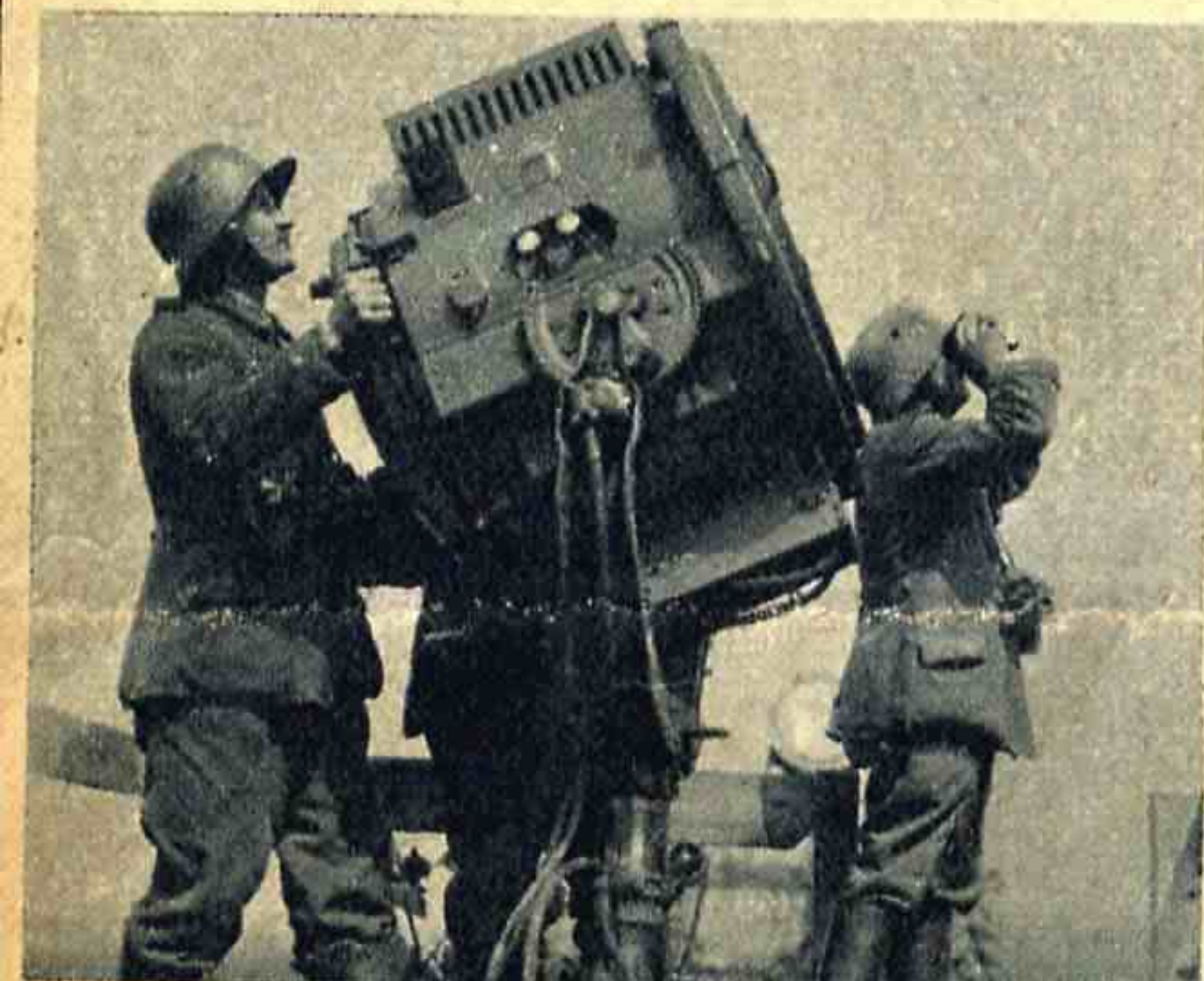
Flugabwehr mit erbeuteten französischen Maschinengewehren. Sie wurden auf Räder von Mähmaschinen gesetzt und auf Pfählen drehbar angebracht
