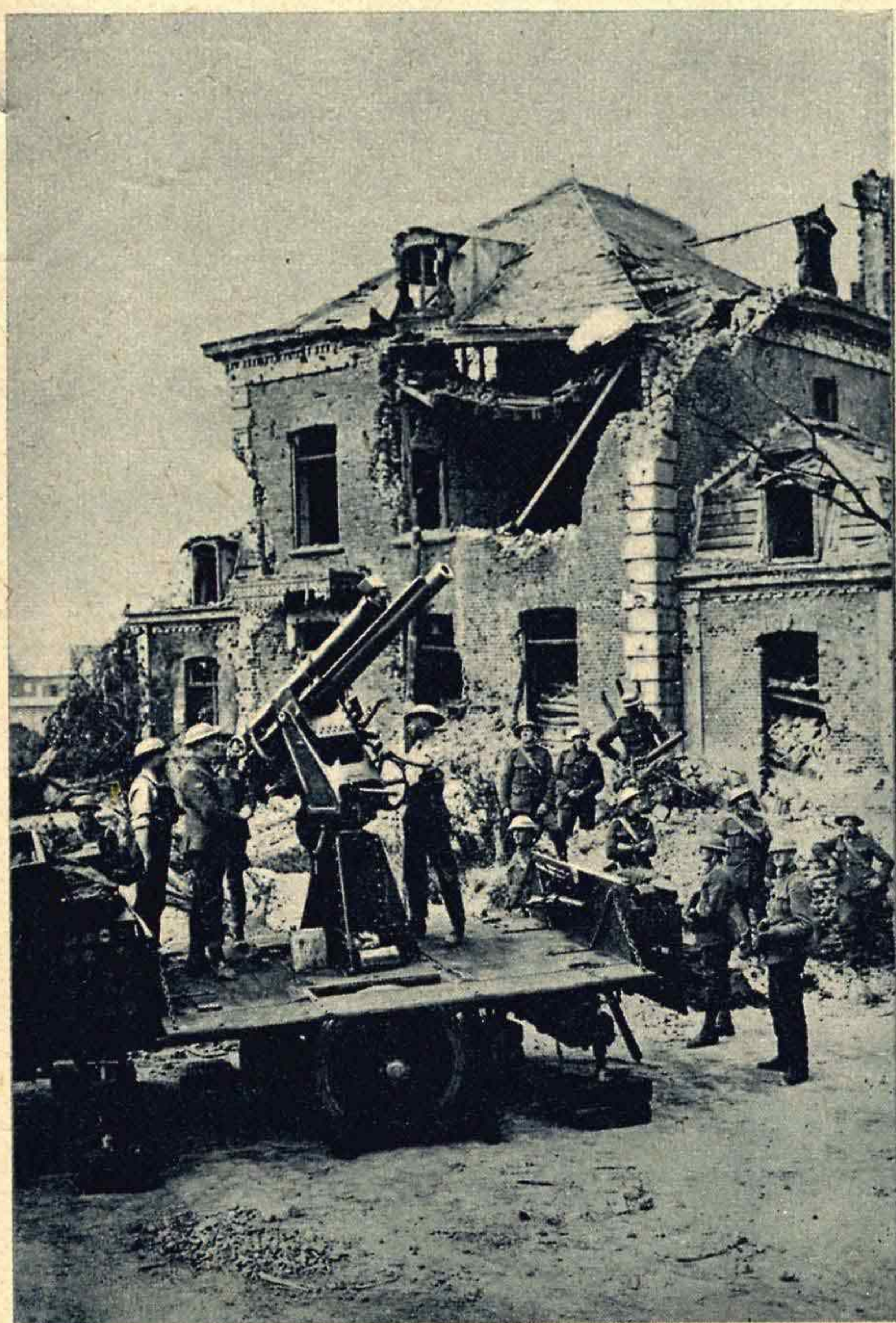
Links: Englische Motor-Flak in Feuerstellung. Zur Verteilung der Rückstoßkräfte ist die Geschützplattform vierfach abgestützt
