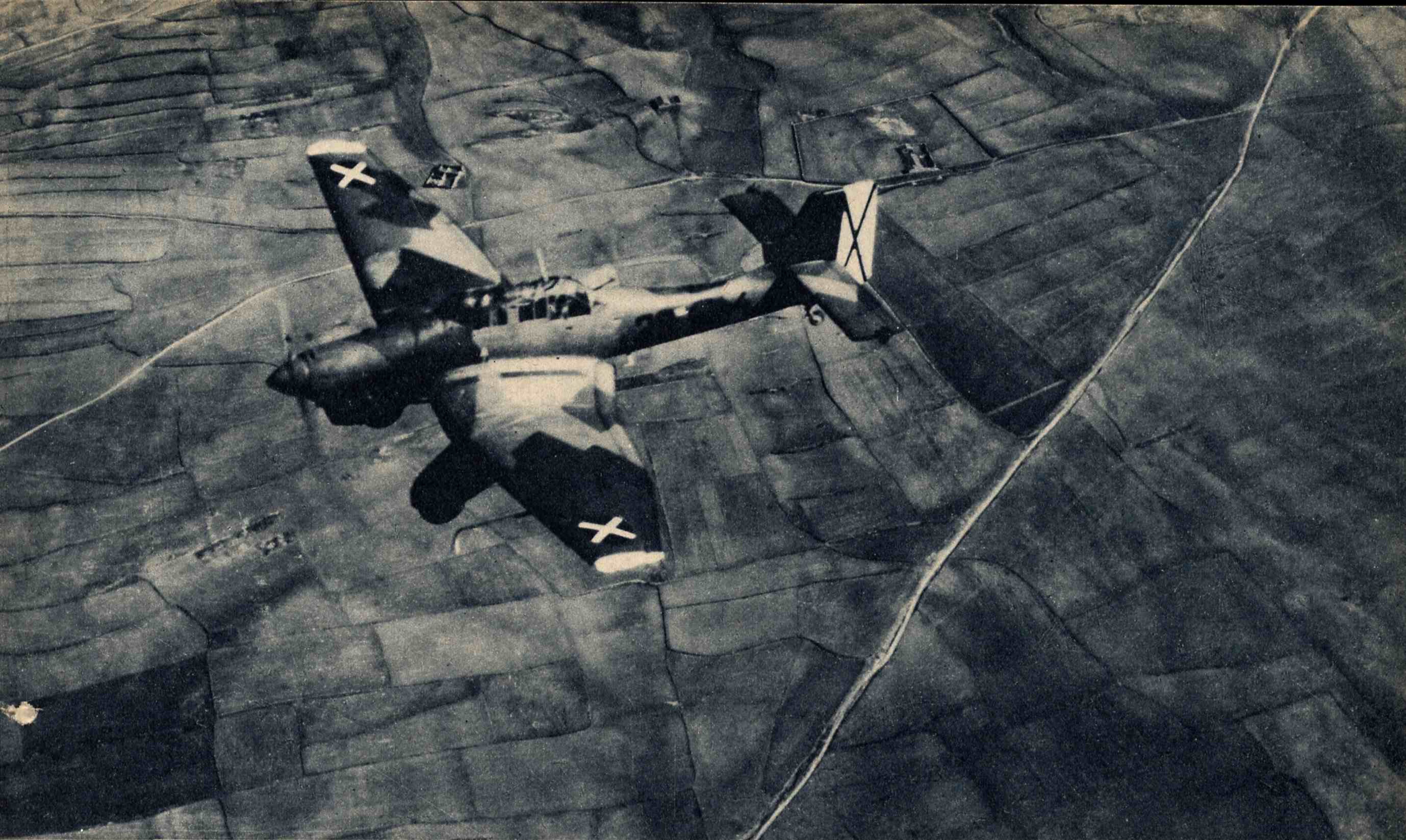
Höhen schwer zu treffen sind, wie Schleusen, Dampfer, Brücken, Straßenkreuzungen und dergleichen. Auf dem Bild links unten ist der Sprengtrichter einer Sturzkampfbombe zu sehen. Die von rechts oben nach links unten führende Straße sollte gesperrt werden. Das Bild zeigt, mit welcher Genauigkeit der Flugzeug-
